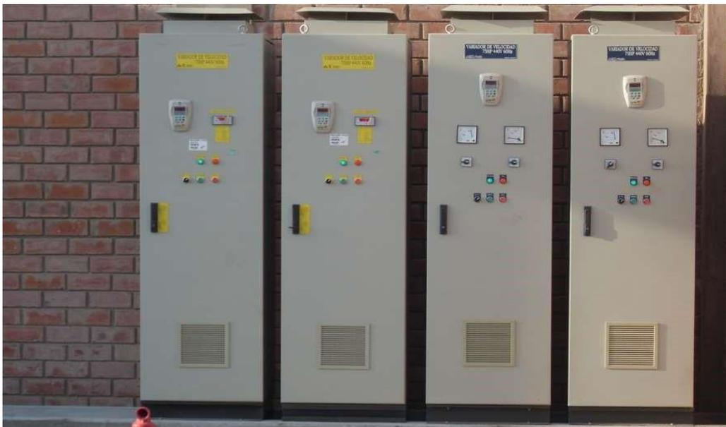
Fig. 2 Tableros de control con variador de velocidad para cada bomba.
