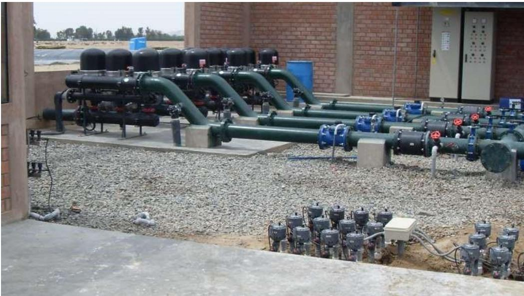
Fig. 4 Vista posterior de los cabezales de filtrado. En primer plano están las válvulas del sistema de inyección de fertilizantes.
