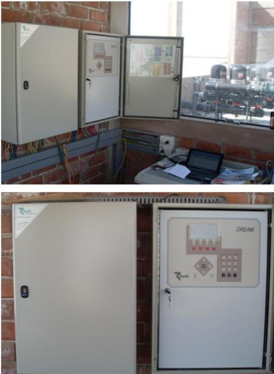
Fig 13. Computadora para el control del bombeo, filtrado, riego y fertilización.
