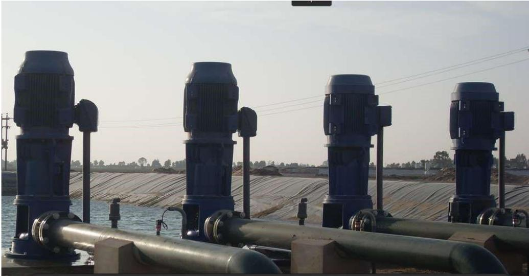
Fig. 1 Bombas verticales de cárcamo sumergido 75 HP, 1,500 GPM @ 45 psi cada una.
