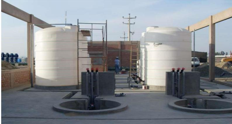
Fig 5. Los tanques enterrados para dilución de fertilizantes se observan en la parte de adelante
