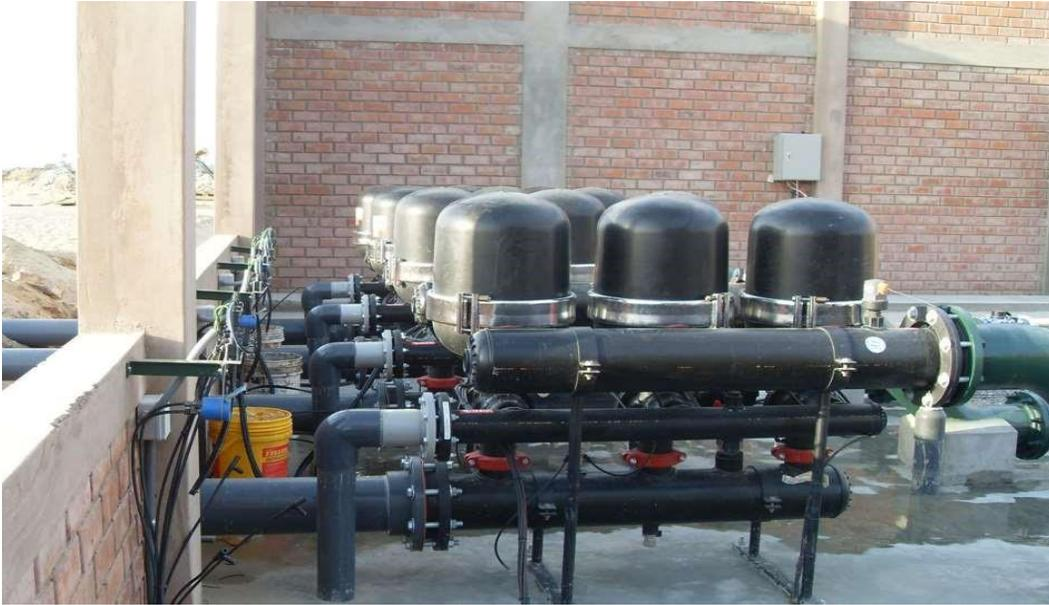
Fig. 3 Un cabezal de filtrado por cada bomba. con tres filtros de discos auto limpiantes, contador volumétrico y válvula cheque por cabezal.
