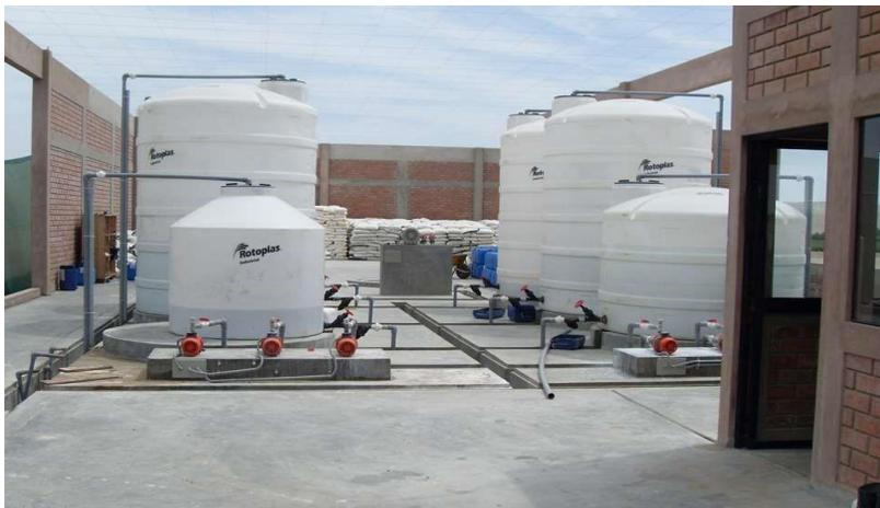
Fig 6. Tanques de almacenamiento de fertilizantes.
