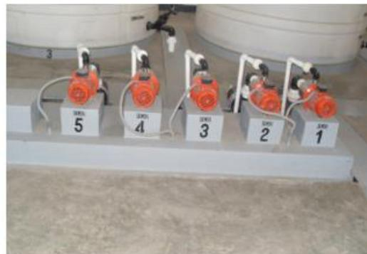
Fig 7. Caudalímetros y bombas de fertilización
